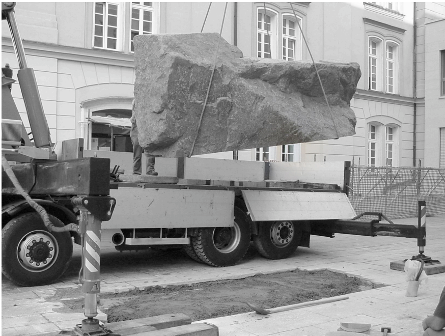
Setzen des Sarner Porphyrtstein im Innenhof der Universität Bolzano/Bozen, 2003
